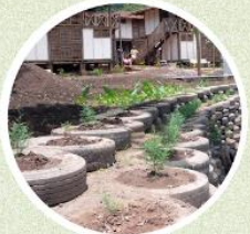
MURO DE LLANTAS Gaviones de alambre de acero
